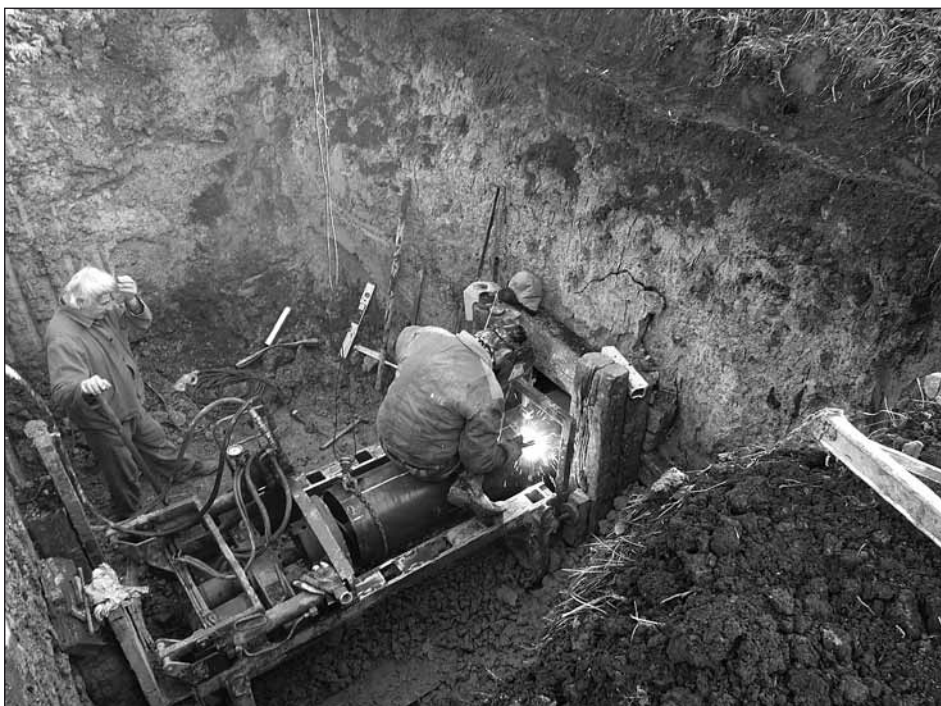
KČOV – provádění protlaku pod silnicí
